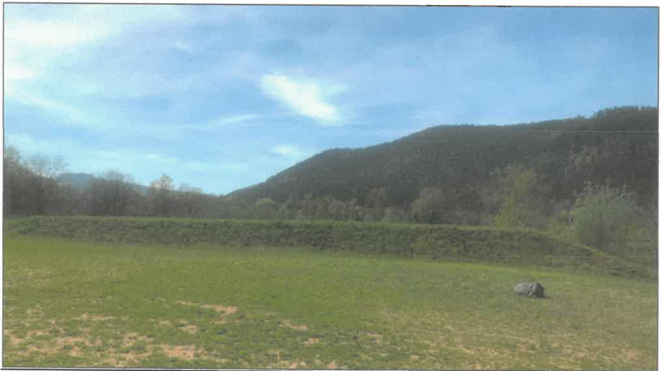
Photo n°2 : Berge située au Sud du site, en amont du premier plan d'eau
