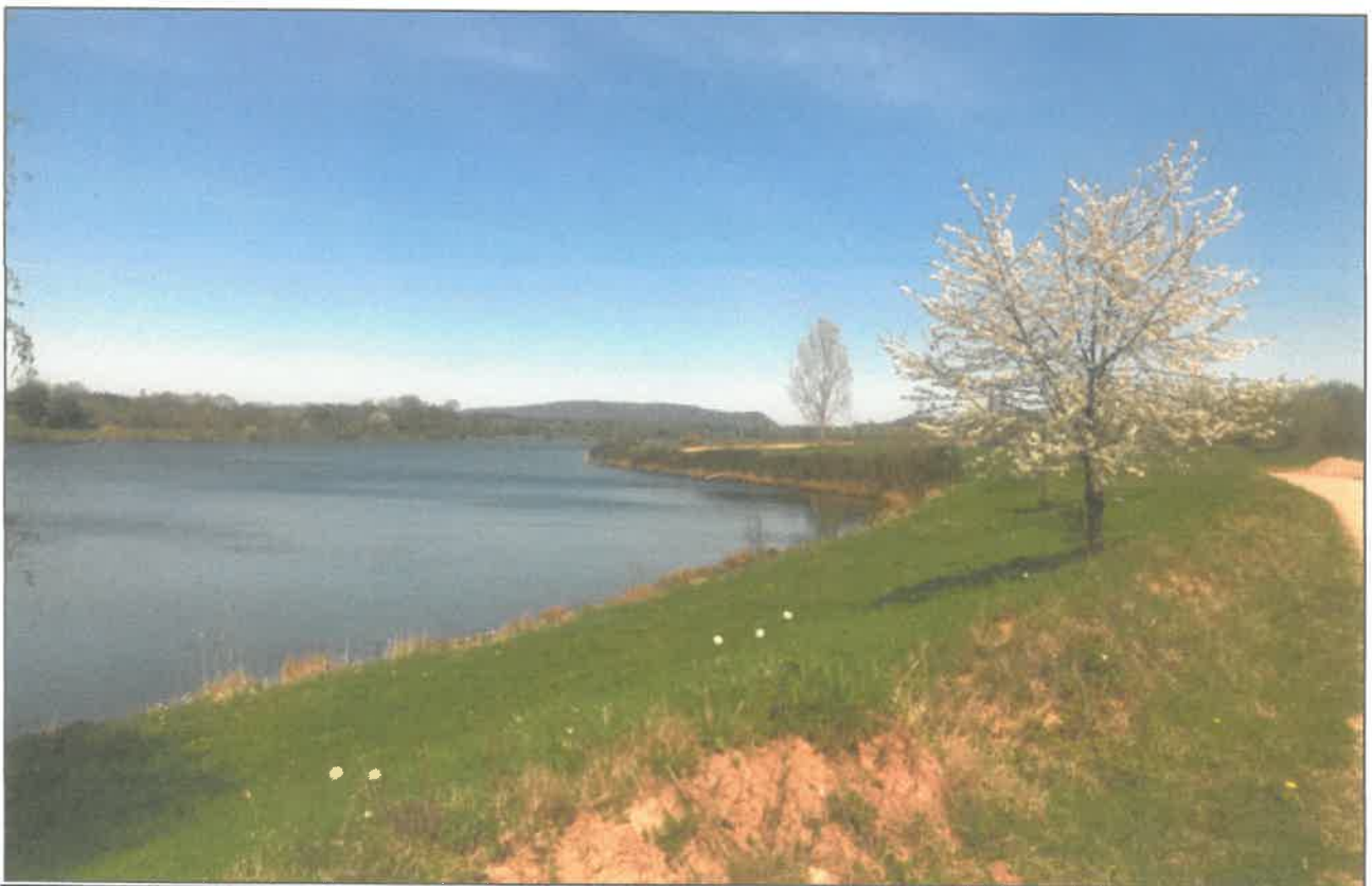
Photo n°4 : Berge Est du plan d'eau amont
