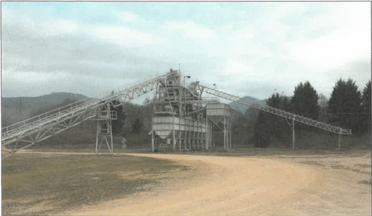
Photo n°13 : Installation de traitement des matériaux avant démantèlement
