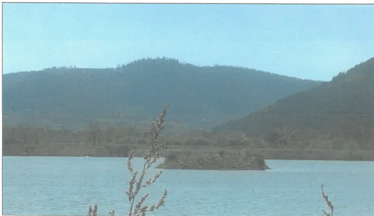
Photo n°8 : Ilot du plan d'eau aval conservé pour le repos et la nidification des oiseaux
