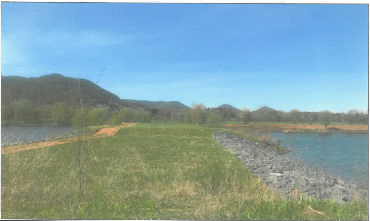
Photo n°6 : Seuil S4 séparant le plan d'eau amont du plan d'eau aval
