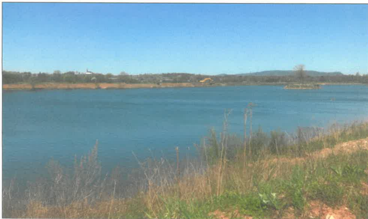
Photo n°7 : Plan d'eau aval vu depuis la berge Est
